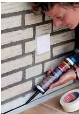
Nakładanie warstwy połączeniowej
