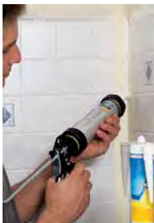
Wypełnianie szczelin w rogach
